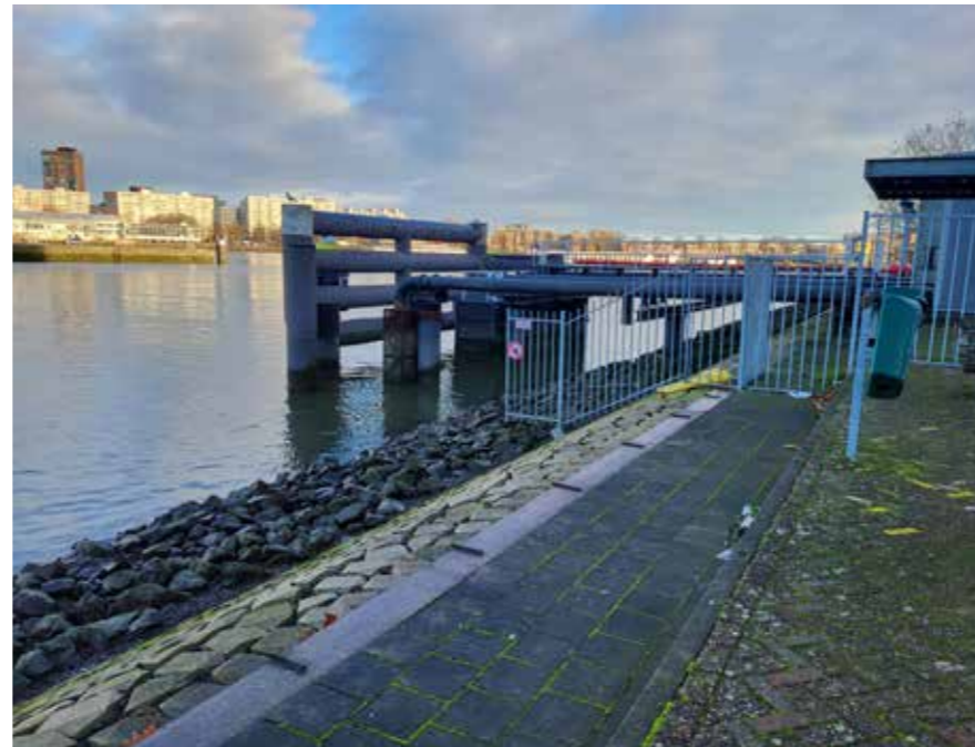
De kade langs de Koningshaven is meestal met soms een onderbreking daarvan. Recentelijk is een talud aangelegd ter versterking van deze kade.
