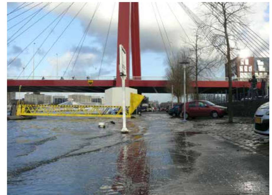
Lager gelegen buitendijkse gebieden zoals het Noordereiland krijgen steeds vaker te maken met wateroverlast door hogere zee- en rivierwaterstanden.
